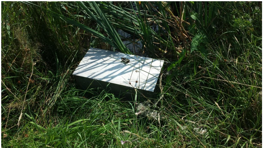
Locatie 6, foto 3. Aan de noordzijde van het ven is een stuw geplaatst
