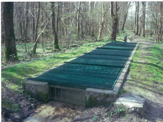
Figuur 8.1 Zandvang en opgeleide Stalebeek nabij Brommelen
