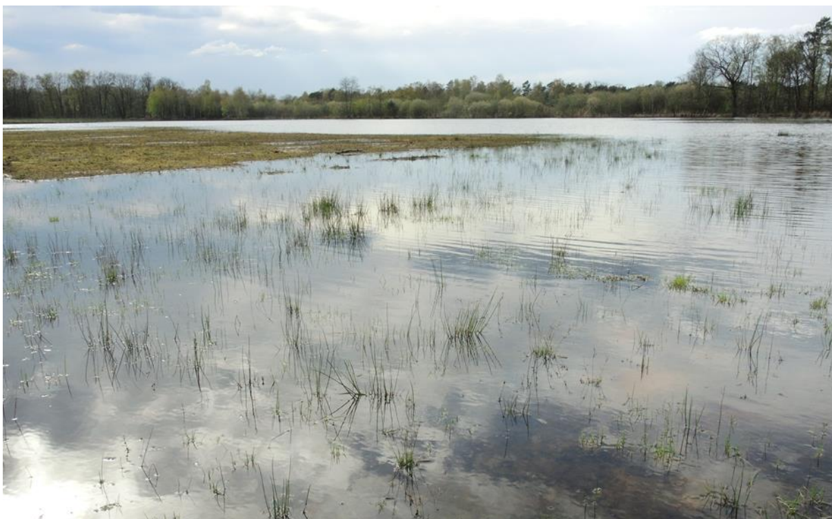
Foto 9 Afgegraven landbouwperceel waarvan het noordelijke en oostelijke deel langdurig zijn geïnundeerd met stagnerend regenwater en oppervlakkig afstromend grondwater doordat aan de stroomafwaartse zijde een hoge dam ligt die dit perceel scheidt van het Greveschutven. De dam en zijn oevers zijn begroeid met wilgenstruweel en berken.
