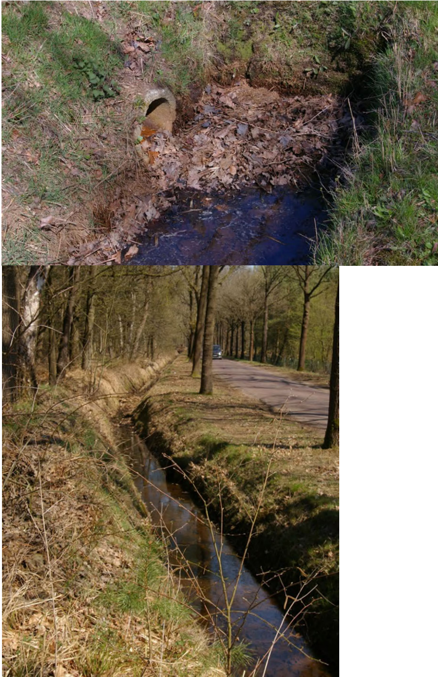
FIGUUR 4-3: FOTO'S VAN (BOVEN) DE AFWATERING VAN HET DRAINAGESTELSEL IN HET ZUIDELIJK DEEL VAN DE REGTE HEIDE OP DE WATERLOOP LANGS DE NIEUWKERKSEDIJKZUID EN (ONDER) DE WATERVOERENDE WATERLOOP LANGS DE NIEUWKERKSEDIJKZUID MET DAARIN EEN DREMPEL VAN ORGANISCH MATERIAAL. DE FOTO'S ZIJN GENOMEN OP 14 APRIL 2015, EEN VOORJAARSDAG NA EEN METEOROLOGISCH GEMIDDELD NATTE WINTER.
