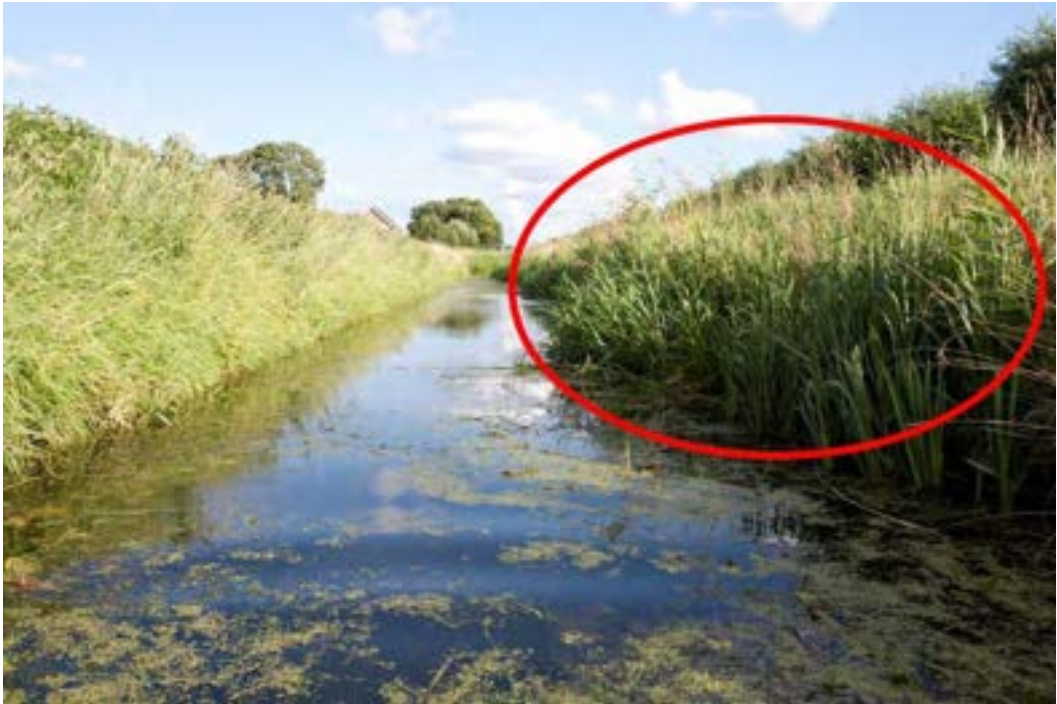
Voorbeeld van schoning waarbij één oever gespaard is maar toch de afvoer gegarandeerd blijft.
