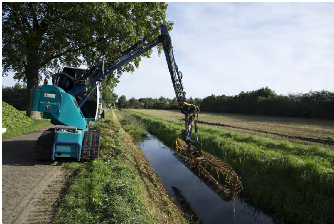
Figuur 2.2 Goormans Waterleiding tijdens slootshoning
