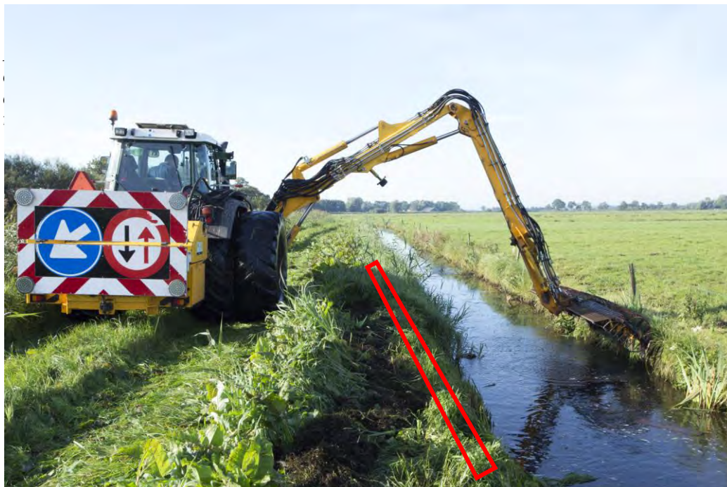
Figuur 5.9 Door tijdens slootshoning boven de modderbodem te maaien en de zijde waar naartoe gewerkt wordt te sparen (rode arcering) hebben vissen veel meer vluchtmogelijkheden.
