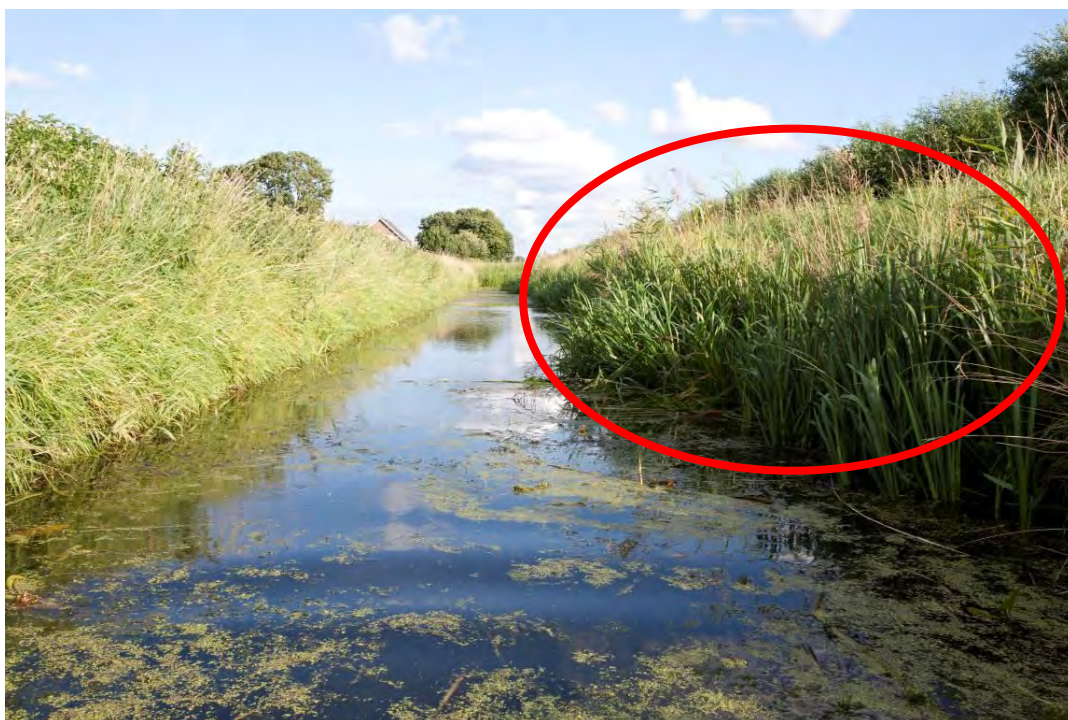
Figuur 5.6 Voorbeeld van schoning waarbij één oever gespaard is maar toch de afvoer gegarandeerd blijft.
