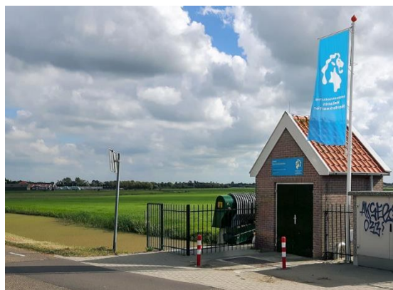
Figuur 3.16 Gemaal Vennewaterspolder (Foto: Edwin Raap, beeldbank.cultureelerfgoed.nl).
