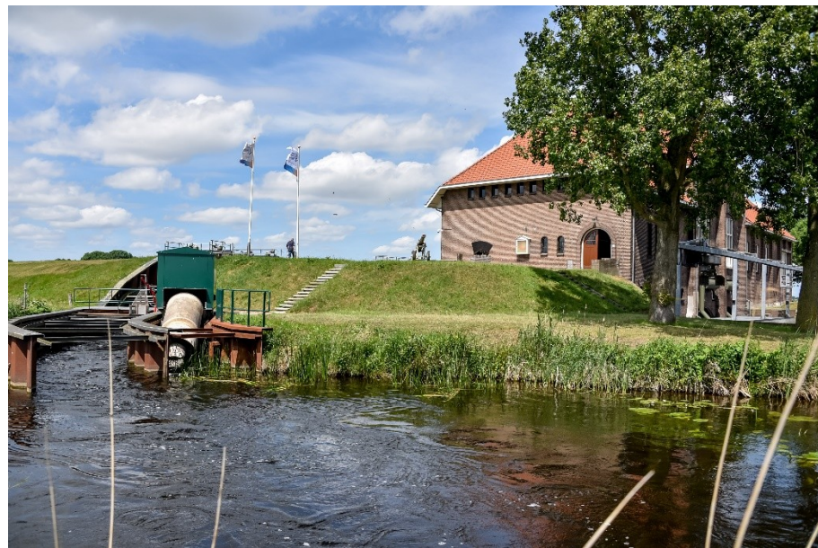
Waterinlaat bij gemaal Stroink
