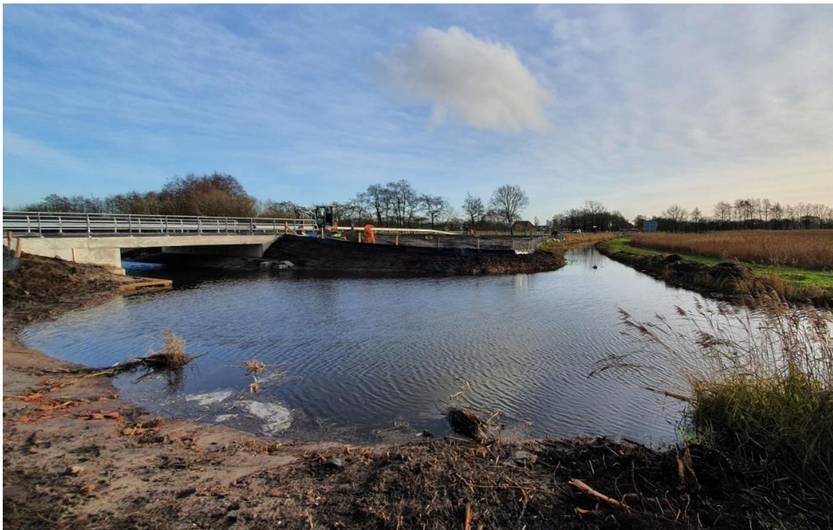
Foto van gerealiseerde verbinding Grootte Wielen en Bouwepet (foto website It Fryske Gea)
