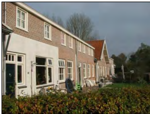
Referentiebeeld (de bestaande woningen)
